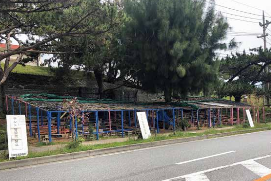
台風接近のためテントが外されたゲート前の集会所
