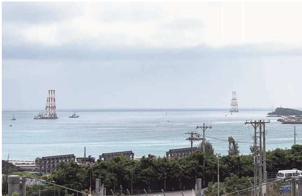
大浦湾から移動する砂杭打設作業船
