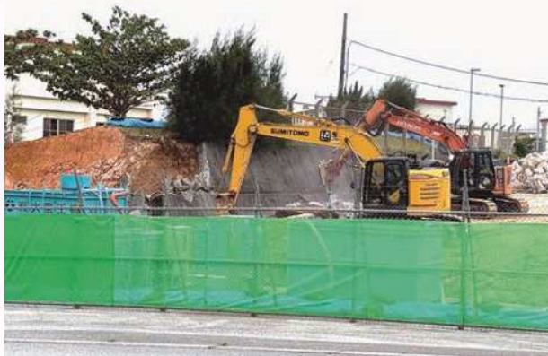
旧工事用ゲートで始まった跨道橋工事
