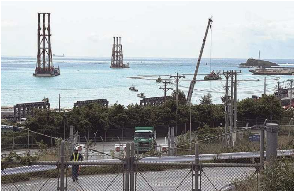
避難せず大浦湾に残る砂杭打設船
