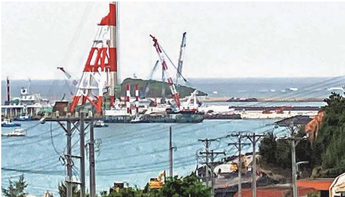
戻ってきた砂杭打設船と土砂投入の現場
