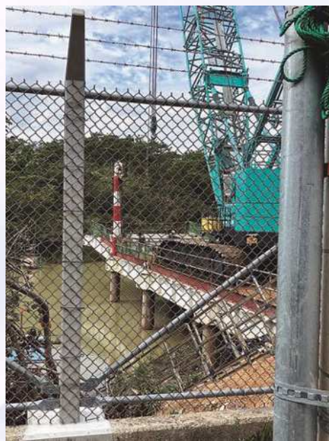
辺野古ダムで進む仮設橋設置工事
