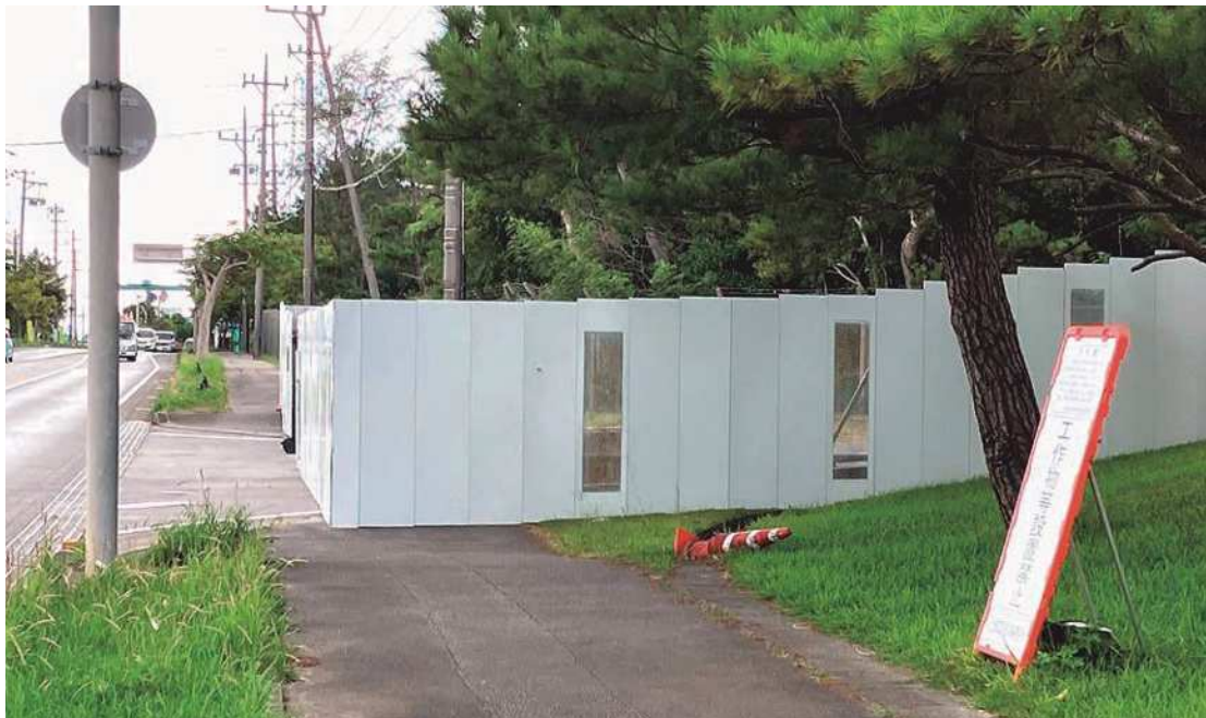
歩道を塞ぐ水道工事現場の壁
