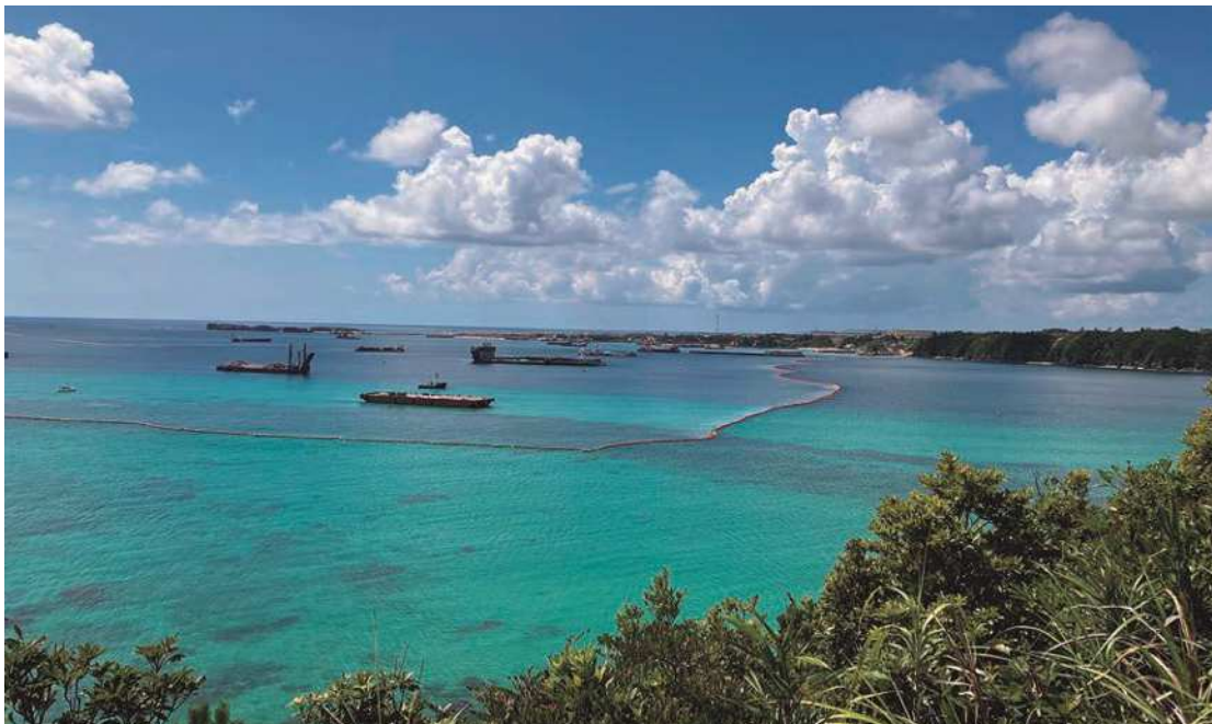
砂杭打設作業船が消えたままの大浦湾
