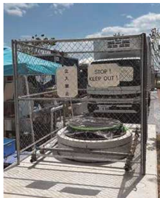
メタンガスが検出されたマンホール
