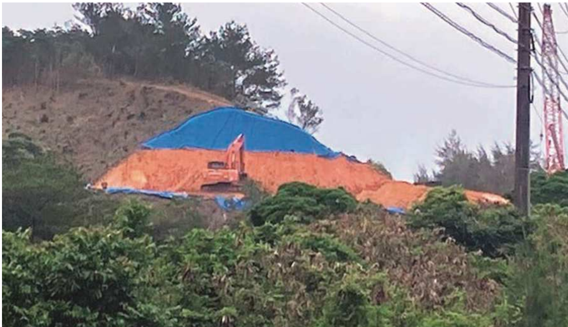
掘削や造成工事が進む辺野古ダム周辺
