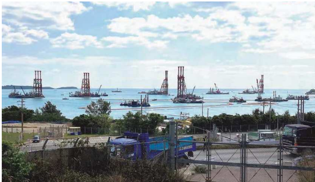
大浦湾を埋め尽くす作業船
