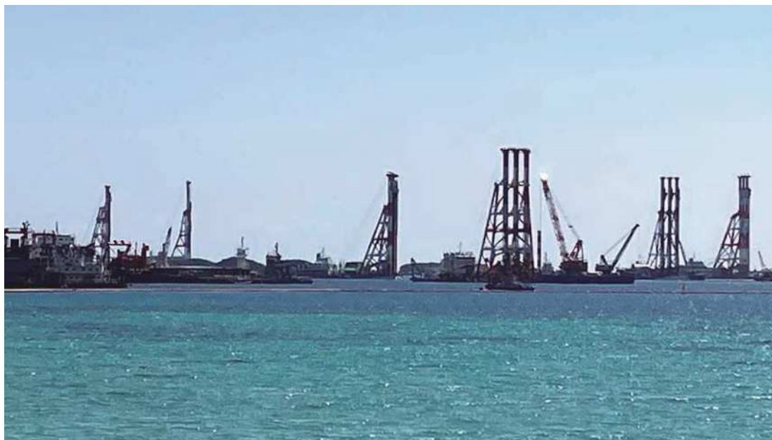
大浦湾に並ぶ6隻の砂杭打設作業船
