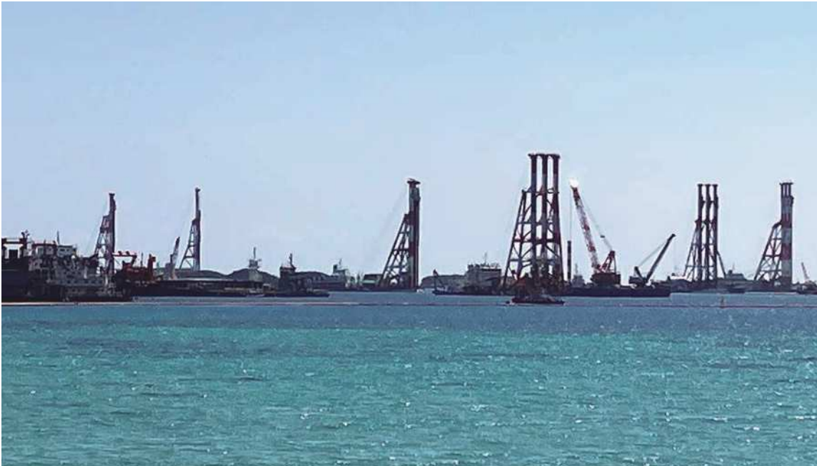
大浦湾に並ぶ6隻の砂杭打設作業船
